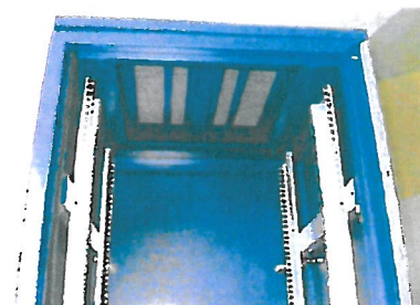
Perforacja w dachu szafy
